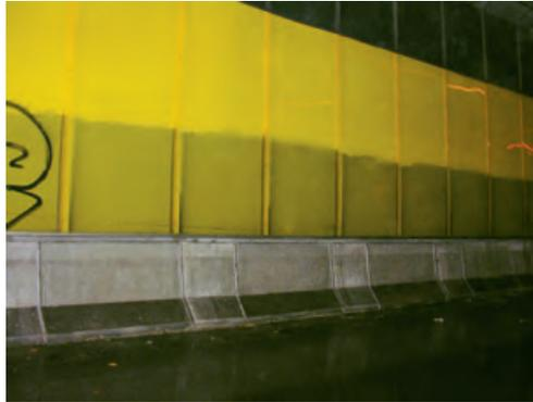
*Nach der Reinigung zeigt sich, dass die Tunnelwände trotz der sehr aggressiven Atmosphäre frei von Korrosionerscheinungen sind. Foto: Centro Inox, Mailand (!)*
