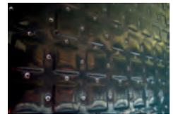
*Absorber von Sonnenkollektoren können auch aus geschwärmtem nichtrostendem Stahl bestehen. Fotos: Energie Solaire SA, Sierre (CH)*
