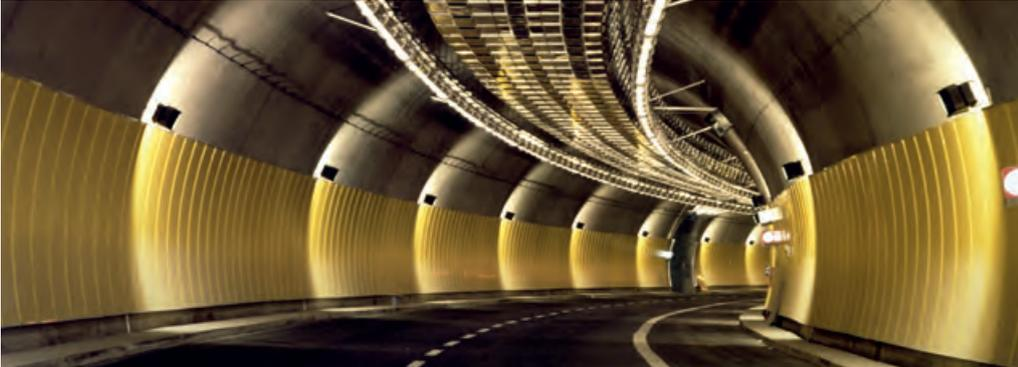
*Die Wandbekleidung dieser Tunnelröhre muss hohen Korrosionsbelastungen widerstehen und soll gleichzeitig Blendwirkungen vermeiden. Foto: ThyssenKrupp Acciai Speciali Terni, Terni (I)*
