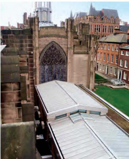
*Durch galvanische Verfahren lassen sich auch dünne Kupferüberzüge auf nichtrostenden Stahl aufbringen. Foto: Roofinox, Schaan (FL)*
