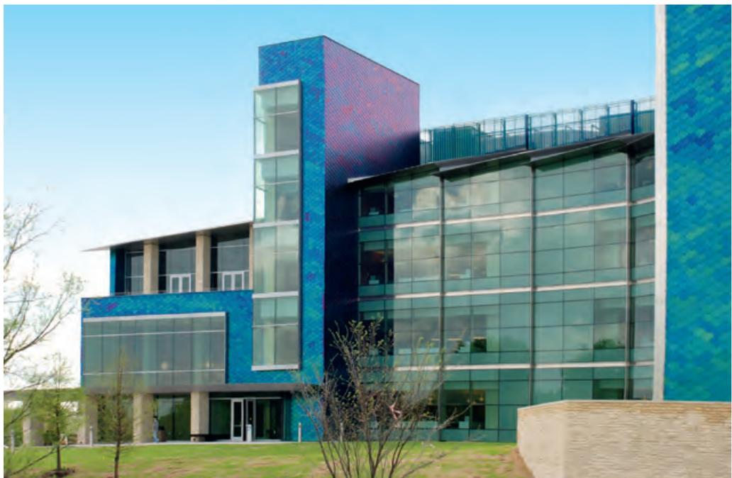
*Elektrolytische gefärbte Oberflächen von nichtrostendem Stahl sind äußerst UV-beständig.
