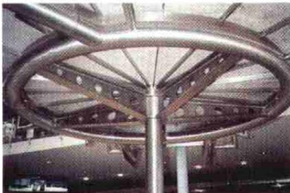
Die Übersicht der Treppenpodestkonstruktion zeigt die teilweise geschweißte, teilweise gesteckte Ausführung.
