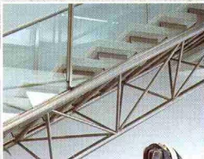
*Die Geländerstäbe aus Edelstahl Rostfrei schließen an die Treppenkonstruktion an. Die Glashalterung erfolgt durch Andruckprofile.*
