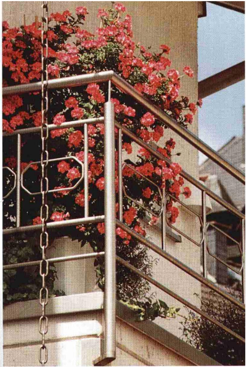
*Die Eckausbildung des Geländers wird durch die konstruktive Ausbildung der Betonplatte erleichtert.*
