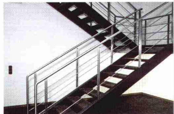
Das Edelstahl-Rostfrei-Geländer an dieser Stahltreppe in einer Sparkassenfiliale in Essen besteht aus parallel zum Handlauf geführten und durch die Geländerstützen gesteckten Füllstäben.
