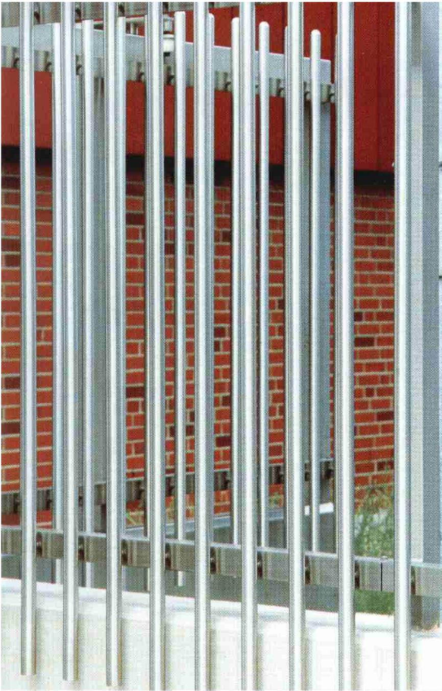
*Durch die Konstruktion aus Rundrohren mit aufgeschweißten Endkappen erhält dieses Geländer an einem Verwaltungsgebäude einen „Staketencharakter“.*
