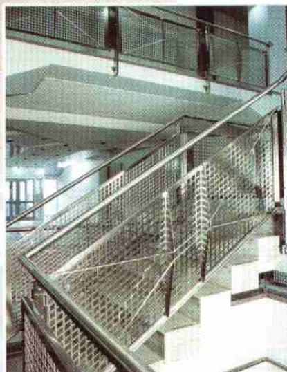
Die Ansicht eines dieser ausgesteiften Brüstungsfelder zeigt, wie die Konstruktion alle Möglichkeiten der Verarbeitung für wirtschaftliche Fertigung und guten optischen Eindruck nutzt.
