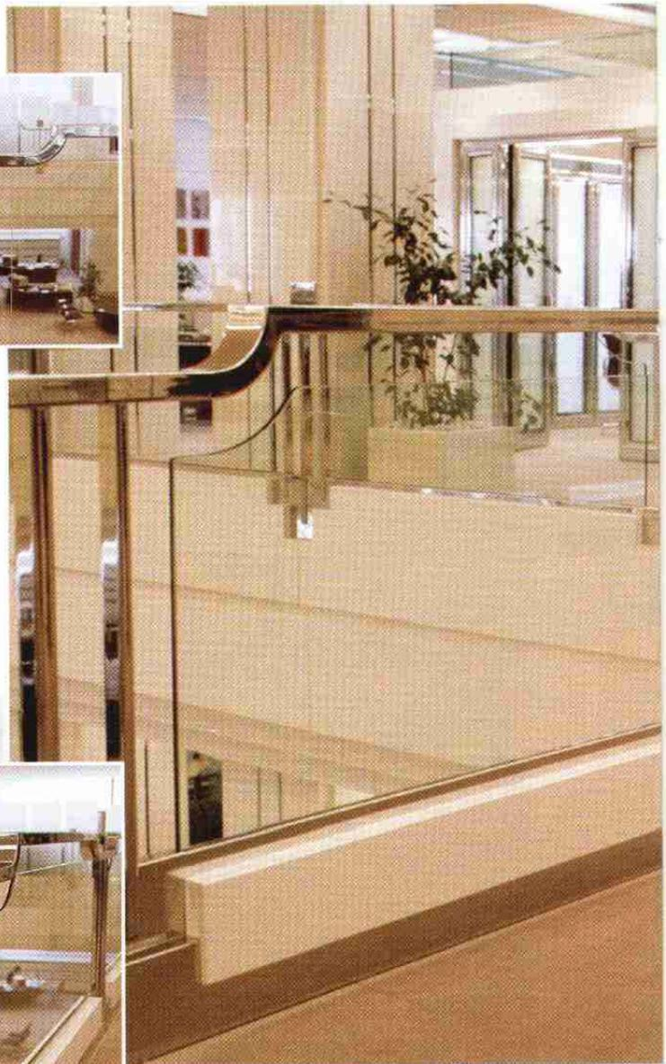
*Das Emporengeländer der Hauptfiliale der Deutschen Bank in Frankfurt/Main ist aus massiven Profilen aus Edelstahl Rostfrei in hochglanzpolierter Ausführung gefertigt.*
