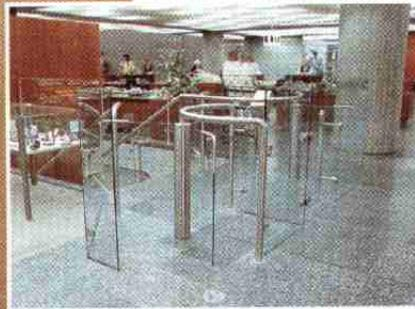
Das Leitgeländer zu den verschiedenen Bereichen der Kundenhalle der Landesgirokasse Stuttgart besteht aus einem Edelstahl-Rostfrei-Rohr, das in einem Stück gebogen ist. Dieses Geländer ist in Elementbauweise mit Sicherheitsverglasungen gefertigt.
