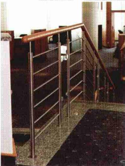
Durch die Verjüngung der Geländerstäbe am Verbindungspunkt wird ein optisch und konstruktiv günstiger Übergang vom Edelstahl-Rostfrei-Geländer zum Handlauf aus Holz geschaffen.
