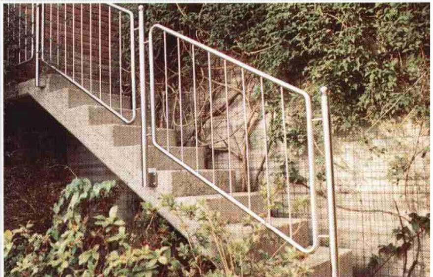
*Die Elementbauweise mit getrennten Pfosten ermöglichte die Werkstattfertigung und schnelle Montage dieses Außentreppengeländers.*
