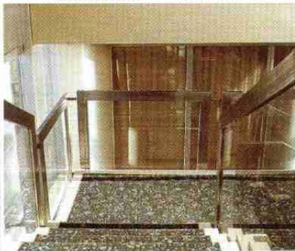
*Die Treppe im Haus des Kurgastes in Hörnum auf Sylt wurde in Elementbauweise mit Sicherheitsverglasung gefertigt. Das Geländer und die Glasleisten bestehen aus Edelstahl-Rostfrei-Rechteckrohren.*
