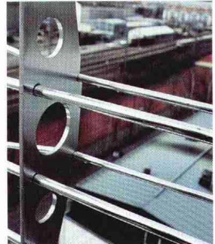
Die Geländerstützen dieses Geländers an einer Dachterrasse bestehen aus Edelstahl-Rostfrei-Blech mit lasergeschnittenen Ausschnitten. Die Querstäbe sind durchgesteckt.
