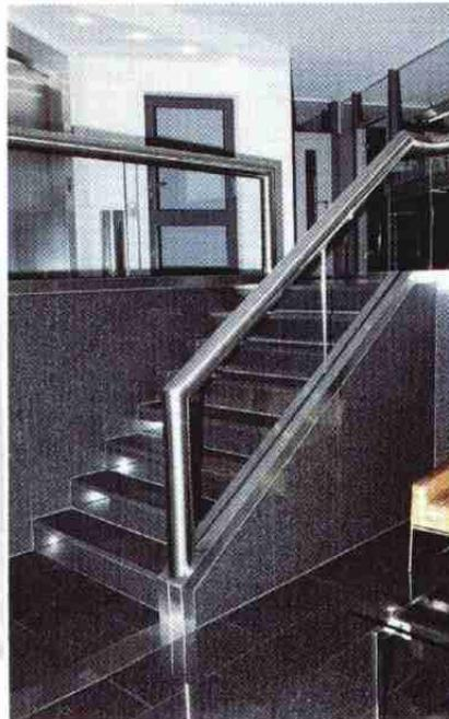
*Die Füllung dieses Geländers besteht aus eingespanntem Glas. Der breite Handlauf ist geschlitzt und nimmt die Kante des Glases auf.*
