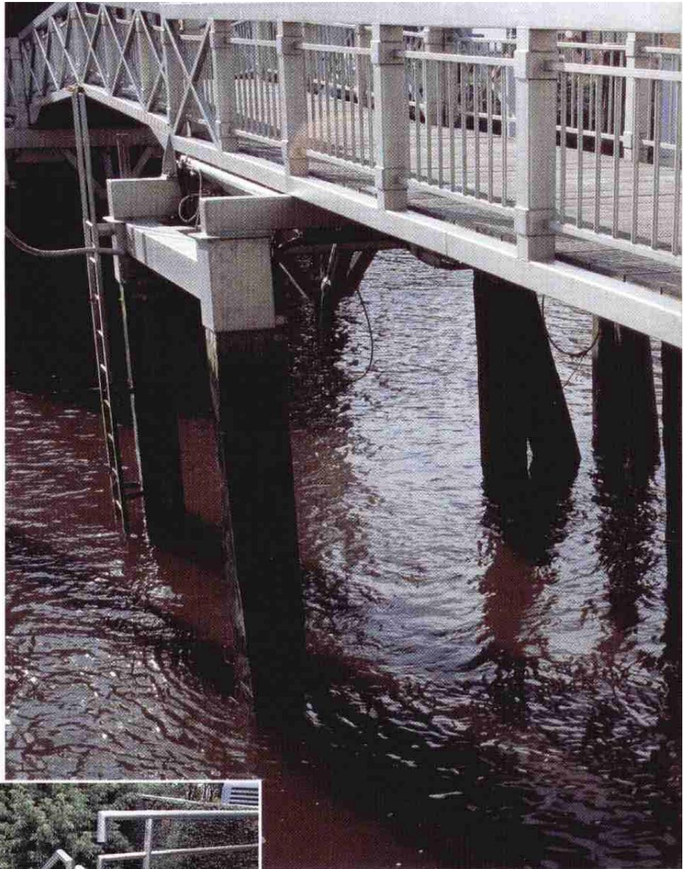
*Diese Fußgängerbrücke überspannt den Binnenhafen in Husum. Das Tragwerk fungiert auch als Geländer. Die Konstruktion, komplett aus Edelstahl Rostfrei, wurde geschweißt und anschließend glasgestrahlt.*
