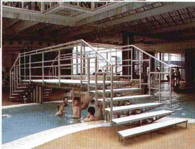
Die besonderen Bedingungen in Hallenbädern – hohe Chloridionenkonzentration und die Gefahr von Ablagerungen – stellen auch an die Verarbeitung sehr hohe Ansprüche. Glatte Oberflächen auch im Bereich von Schweißnähten sind eine Voraussetzung für die Korrosionsbeständigkeit der Bauteile.
