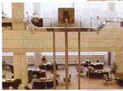
*Das tragende Konstruktionselement ist dreiteilig. Ein durchlaufendes Grundprofil aus Edelstahl Rostfrei nimmt die Natursteineinsätze auf. Die Verglasung ist in der Bodenschiene eingespannt.*
