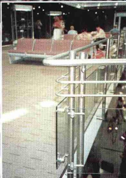
*Durch die Ausbildung der Ecke des Brüstungsgeländers mit Doppelstützen können Handlauf und Geländerstäbe frei vor der Konstruktion gebogen werden.*
