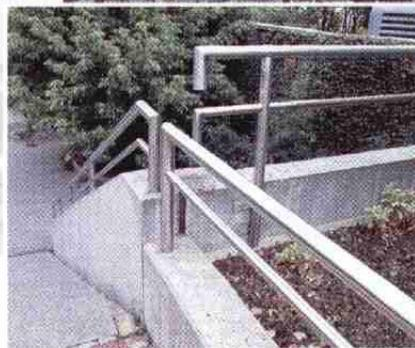
*Außengeländer vor der Kreisverwaltung Lüneburg: Durch bewußte Trennung der werkstattgefertigten Geländerelemente werden Schweißen und Schleifen auf der Baustelle vermieden.*
