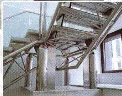
*Das Podest wird lediglich durch zwei Stützen aus Edelstahl Rostfrei getragen.*
