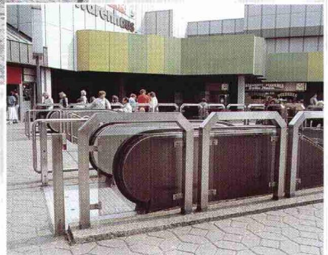
*Die hier aus Rechteckrohren gebauten Geländerelemente zeigen den typischen Gehrungsschliff.*
