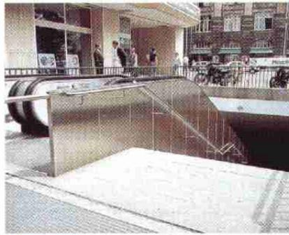
Die Fahrtreppenwangen und das Brüstungsgeländer sind aus Edelstahl Rostfrei und sorgen für einen sicheren Treppenaufgang vor U-Bahnen, hier an der Station „Hauptwache“ in Frankfurt/Main.
