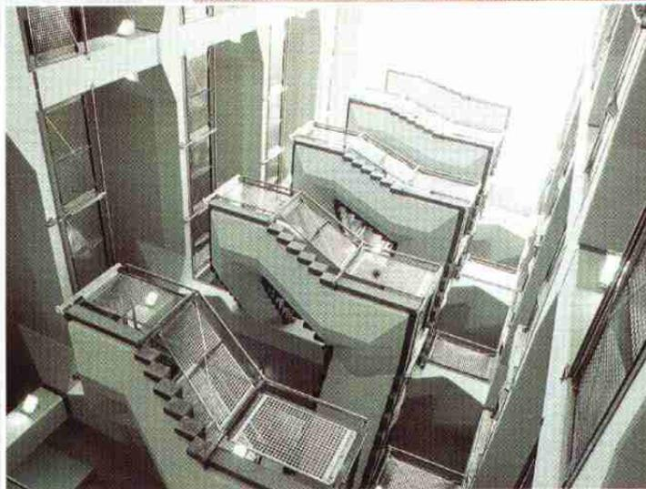
Die Geländerfüllungen dieses Treppen- und Brüstungsgeländers in einem Bürogebäude bestehen aus Edelstahl-Rostfrei-Lochblechen. Bei großen Abmessungen sind die Bleche durch Rundstäbe in Kreuzform ausgesteift.
