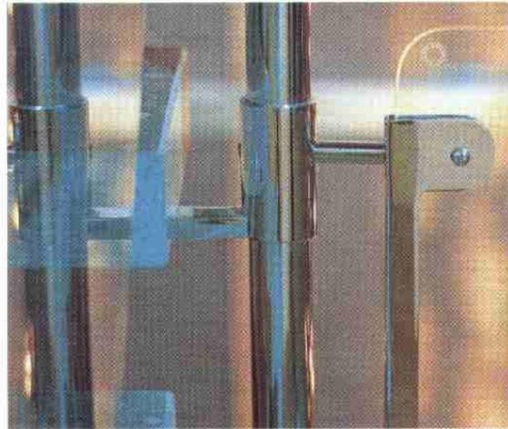
*Eine aufwendige Nachbearbeitung der Edelstahl-Rostfrei-Oberfläche entfällt bei dieser Ausführung: Die Tragstäbe sind durch geschraubte Hülsen verbunden, die Glashalterungen geschraubt.*
