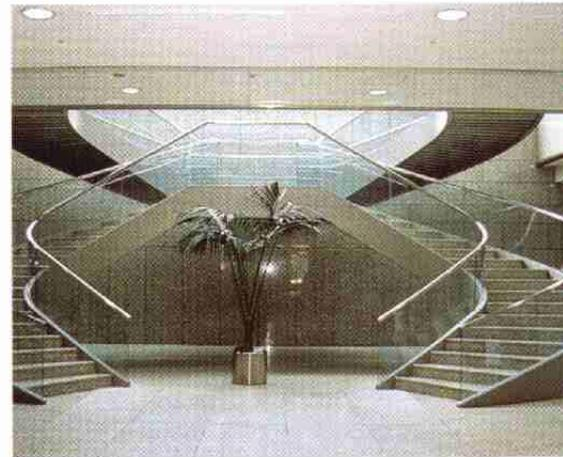
*Auch dieser Handlauf ist auf ein eingespanntes Glasgeländer aufgesetzt.*
