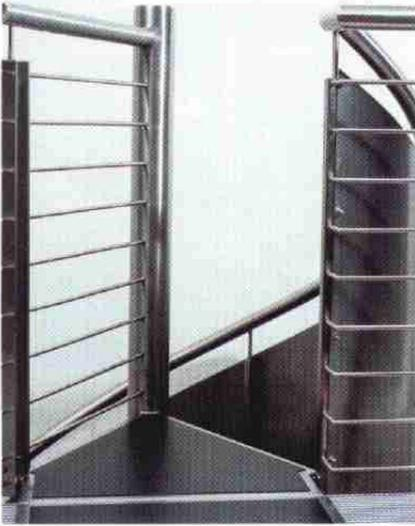
*Diese Verbindung der Geländerfüllstäbe mit den Tragstäben zeigt eine besonders wirtschaftliche Anschlußlösung.*
