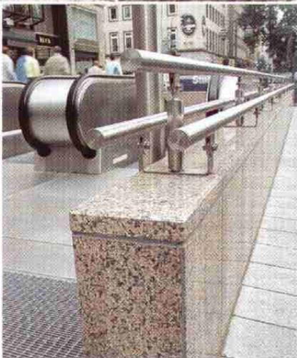
*Durch die Schraubmontage wird eine gute Anpassung dieses Geländers an die örtlichen Gegebenheiten am U-Bahneingang „Steinstraße“ in Düsseldorf erreicht. Der konstruktive Abschluß erleichtert das Ausrichten. Die Abschlußdeckel der Handlaufrohre sind eingeschraubt bzw. geklebt, um aufwendige Oberflächenbearbeitung zu vermeiden.*
