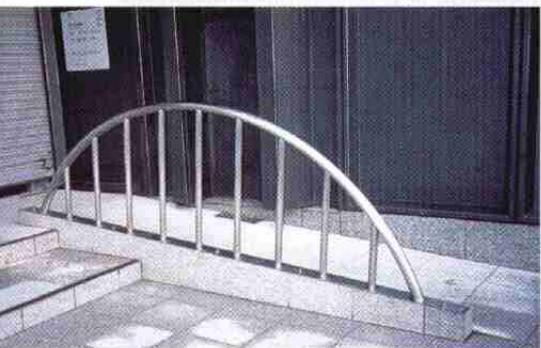
*Dieser Schutzgeländerbügel aus Edelstahl Rostfrei sichert den Rollstuhlfahrerbereich.*
