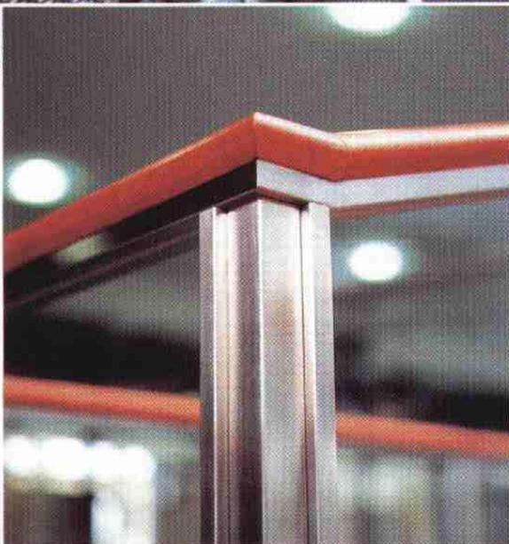
*Nichtrostende Rechteckprofile sind konstruktiv zu empfehlen, da die Oberfläche vor dem Zusammenbau der Einzelteile gut bearbeitet werden kann.*
