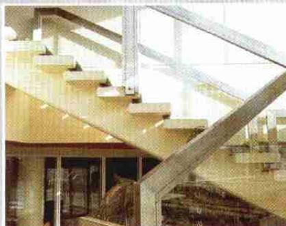
*Durch entsprechenden Schliff werden die Gehrungen der Geländerkonstruktion besonders betont.*
