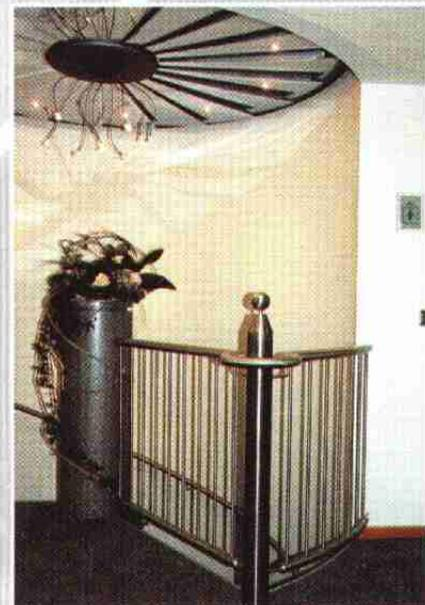
*Dieser Treppenaustritt zeigt eine elegante Lösung des Geländeranschlusses und -abschlusses. Pfosten und Handlauf aus Edelstahl rostfrei wurden aufwendig gestaltet.*
