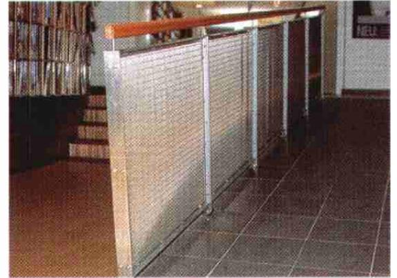
*Nichtrostendes Drahtgewebe als Geländerfüllung ist eine reizvolle, filigrane Lösung, besonders in Verbindung mit Holz.*
