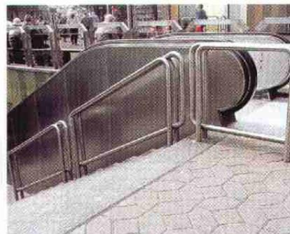
Die konsequente Verwendung von Einzelteilen, wie hier am Rathausvorplatz in Essen, ermöglicht die komplette Vorfertigung in der Werkstatt. Eine Bearbeitung auf der Baustelle erübrigt sich.
