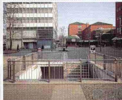
Diese Geländerkonstruktion ermöglicht es, die Fugestellen in den nicht sichtbaren Bereich der Stützen zu legen. Die Nachbehandlung der Schweißnähte braucht deshalb keinen besonderen optischen Anforderungen zu entsprechen.
