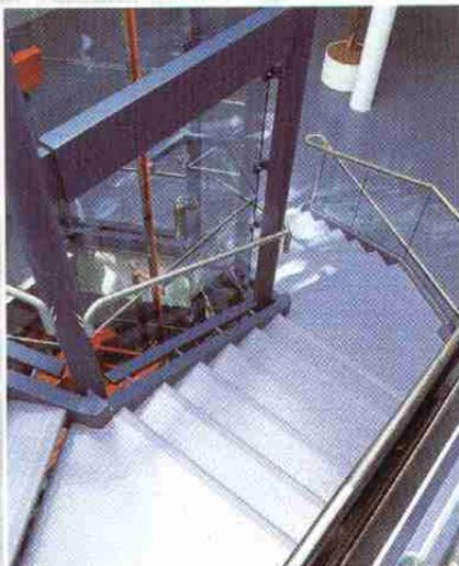
Der Handlauf rechts aus geschlitztem Edelstahl-Rostfrei-Rohr wird auf ein in ein weiteres Edelstahlrohr eingespanntes Geländer aus Glas aufgesetzt. Der linke Handlauf ist in Elementkonstruktion entsprechend dem Treppenlauf ausgeführt.
