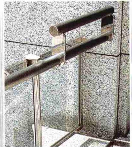
Der zweite Handlauf über diesem Geländerabschluß an einem Gebäude schafft die erforderliche Geländerhöhe an einer aufsteigenden Stufe.
