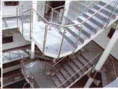
Die Handlaufführung unterstreicht die Treppenkonstruktion. Die Befestigung des Treppen- und Brüstungsgeländers aus Edelstahl Rostfrei am Beton ist geschraubt. Die Verglasung erfolgt mit geschraubten Glashaltern. Der Handlauf ist über Eck gestoßen und geschweißt.
