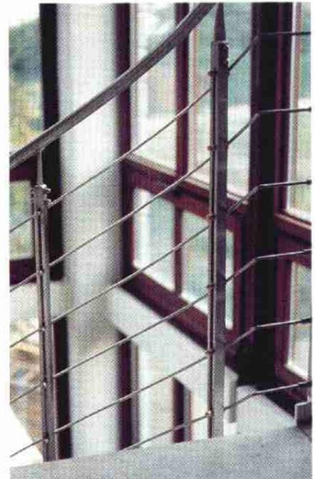
*Raffiniertes Detail: Die Füllstäbe sind in Durchsteckmontage mit den Doppelstützen verbunden. Der Handlauf ist mit dem sich verjüngenden Stützenprofil verschweißt.*
