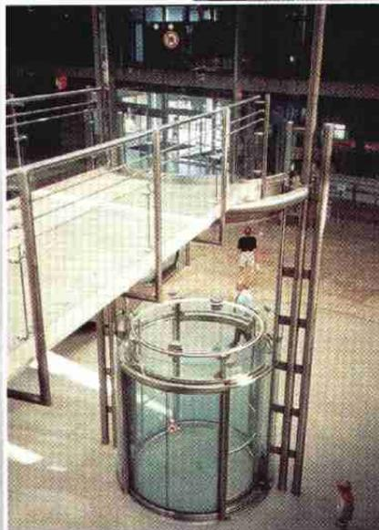
Die tragende Funktion der Profile für Podest und Aufzuganlage ist deutlich zu erkennen.
