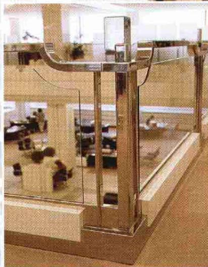
*Die Eckausbildung des Geländers erfolgt durch verstärkte Pfosten aus Edelstahl Rostfrei.*
