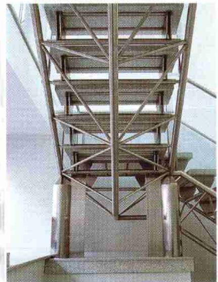
*Die Untersicht der Treppenanlage zeigt die WIG-geschweißte Gitterkonstruktion.*
