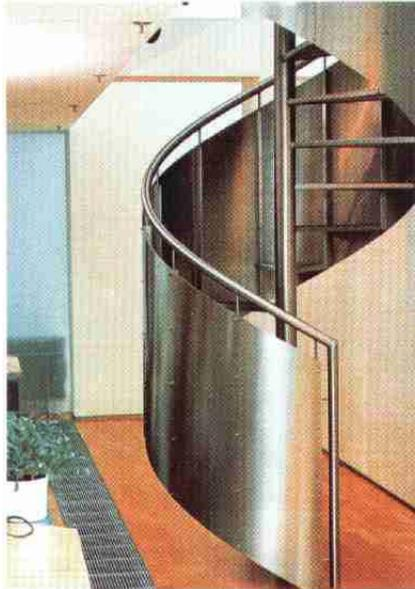
Für die komplett aus Edelstahl Rostfrei konstruierte Wendeltreppe in der Sparkasse Saarbrücken wurde eine Geländerfüllung aus gebogenem Edelstahl-Rostfrei-Blech gewählt. Das setzt präzises Biegen und eine einwandfreie Oberflächenausführung voraus.
