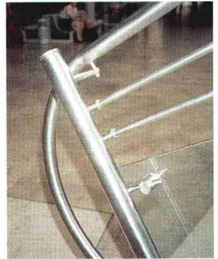
*Dieser Geländerendpunkt zeigt eine gestalterisch und konstruktiv vorteilhafte Anschlußlösung für Glas, Geländerstäbe und Handlauf. Die Abschlußkappe der Geländerstütze wird gesteckt.*
