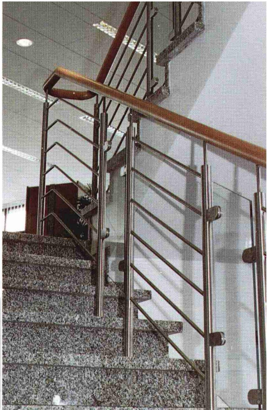
Die Elementbauweise an einem Treppengeländer in einer Sparkassendirektion führt zu einem interessanten Wechsel von Edelstahl-Rostfrei-Stäben und Verglasung.
